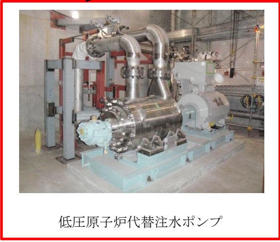
図 2 低圧原子炉代替注水系（常設）による原子炉注水に係る機器（低圧原子炉代替注水ポンプ）の配置図
