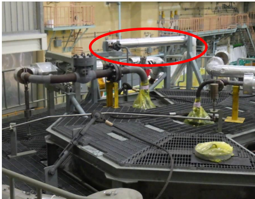
第41-1-6図 ベント配管の設置例
