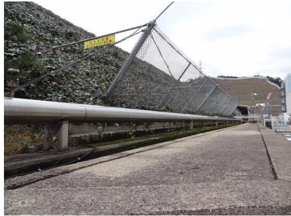
屋外消火配管の地上化
