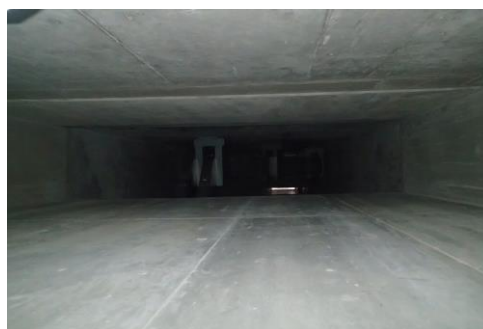
B-非常用ディーゼル発電機 給気消音器フィルタ室内
