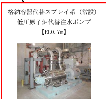
低圧原子炉代替注水ポンプ格納槽
