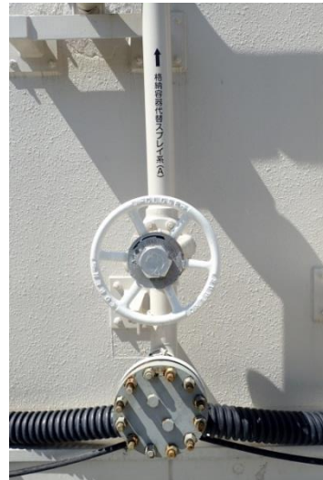
ACSS A-注水ライン 流量調整弁 (V2B5-1A)
