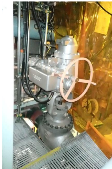
A-RHRドライウエル第1 スプレイ弁 (MV222-3A)
