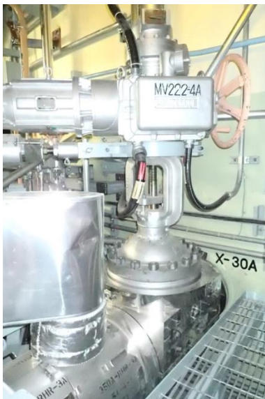
A-RHRドライウエル第2 スプレイ弁 (MV222-4A)
