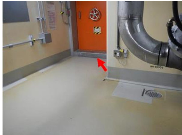
第 41-1-2 図：堰による拡大防止対策概要図
