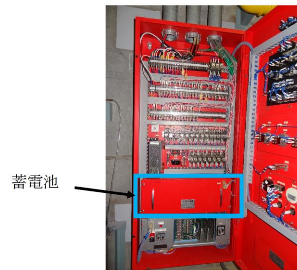
第41-1-24図 消火設備の電源確保の概要
