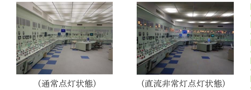
図 2.5-4 直流非常灯照明下での中央制御室のイメージ (シミュレータの点灯例)
