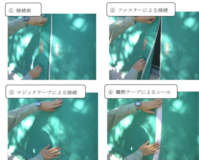
第3.3-9図 各テントハウス間の接続 (イメージ)
