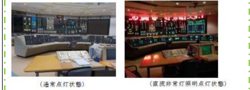
図 2.5-5 非常灯照明下で中央制御室の状況
