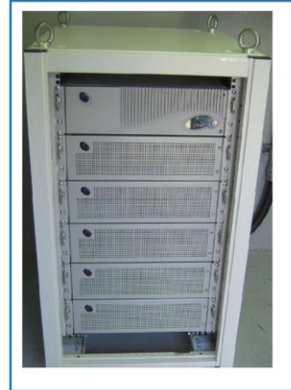
無停電電源装置
