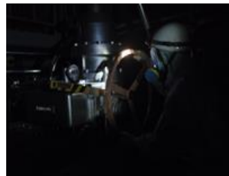
可搬型照明を使用した 状態での作業
