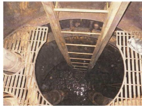
写真C 揚水井戸⑦(下段部) 2017/3/16撮影
