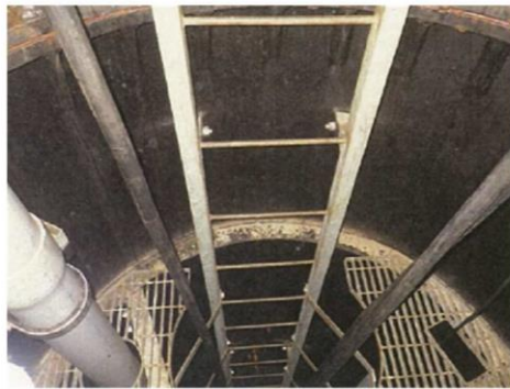
写真B 揚水井戸⑦(中間部) 2017/3/16撮影
