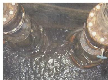
2号炉揚水ポンプの例(揚水井戸⑥)
