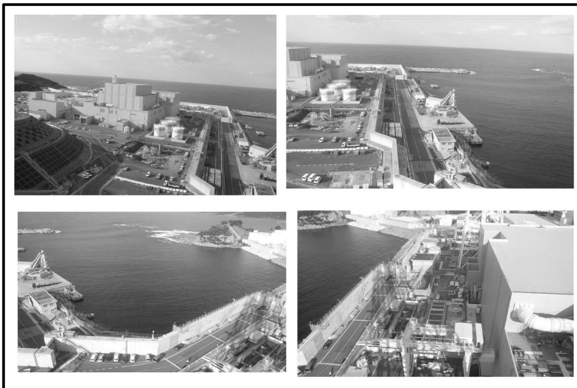
第4.3-3図 津波監視カメラ映像イメージ（排気筒E L. +64.0m）
