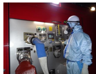
ポンプ起動操作（夜間）
