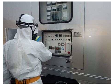
高圧発電機車での作業
