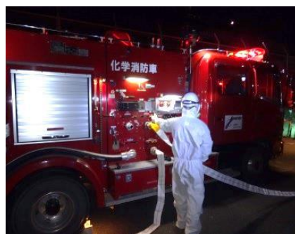
ポンプ起動操作（夜間）
