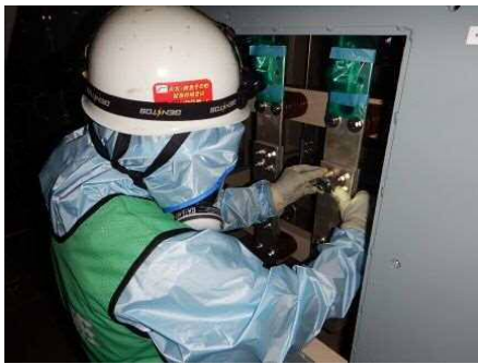
ボルトリンク接続作業
