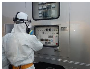
高圧発電機車での作業
