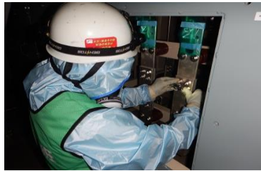
ボルトリンク接続作業
