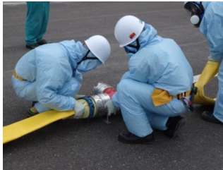
ホース接続作業（昼間）
