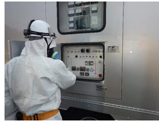
高圧発電機車での作業
