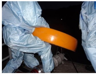
水中ポンプ設置準備（夜間）
