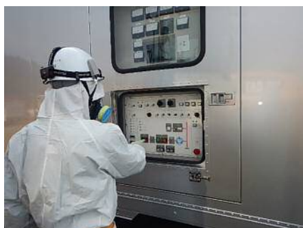
高圧発電機車での作業
