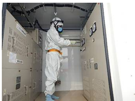
直流給電車での作業
