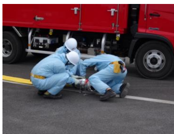
ホース接続作業（昼間）
