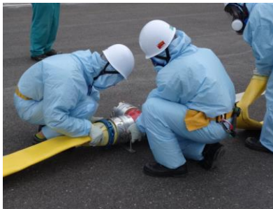
ホース接続作業（昼間）
