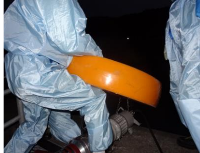
水中ポンプ設置準備（夜間）
