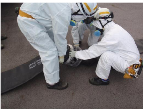
ホース接続作業
