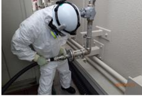
ホース接続作業
