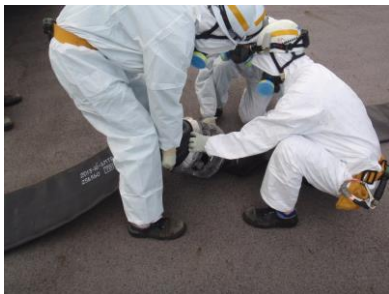
ホース接続作業
