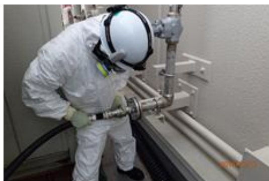
ホース接続作業
