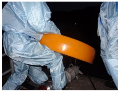
水中ポンプ設置準備（夜間）
