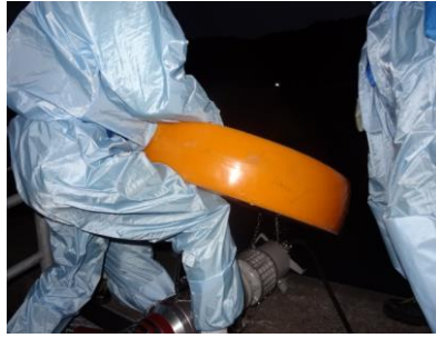
水中ポンプ設置準備（夜間）
