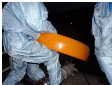
水中ポンプ設置準備（夜間）
