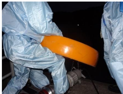
水中ポンプ設置準備（夜間）
