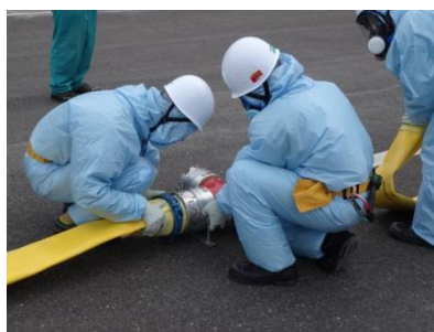
ホース接続作業（昼間）
