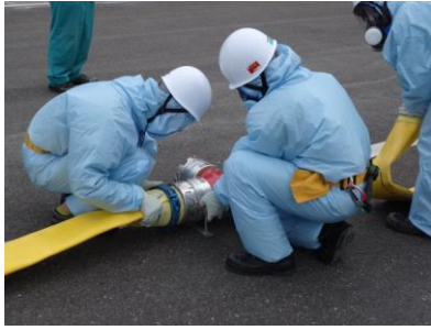
ホース接続作業（昼間）
