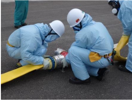
ホース接続作業（昼間）
