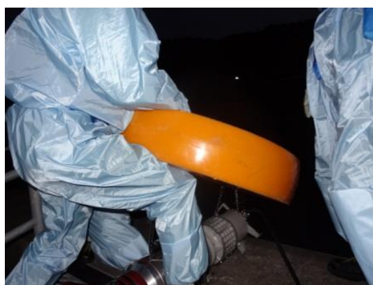
水中ポンプ設置準備（夜間）
