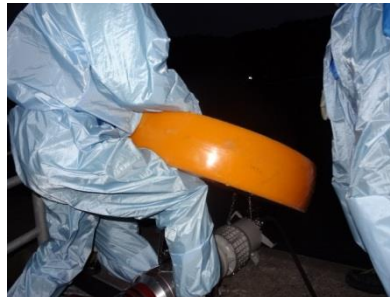
水中ポンプ設置準備（夜間）
