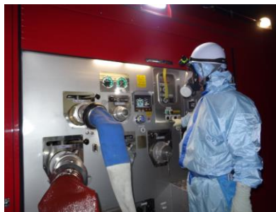
ポンプ起動操作（夜間）
