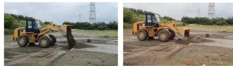
段差復旧状況①
