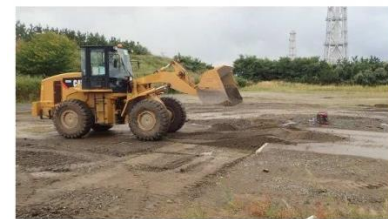
段差復旧状況③
