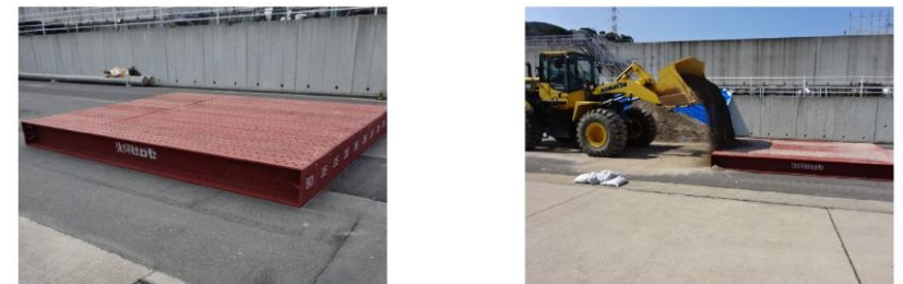
第6図 段差復旧状況
