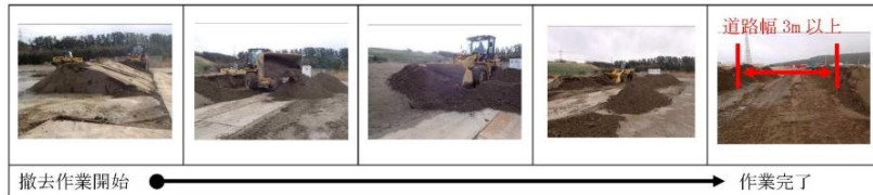
第 10 図 土砂撤去状況写真
