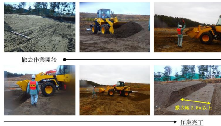
第 8 図 土砂撤去検証の写真
