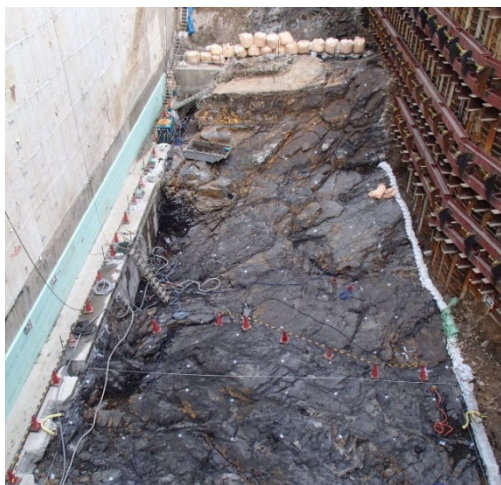
掘削面 (T. P. -5.0m)
