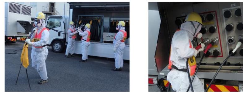
第1.0.13-4 図 放射線防護具類を着用した状態での電源車のケーブル敷設作業
