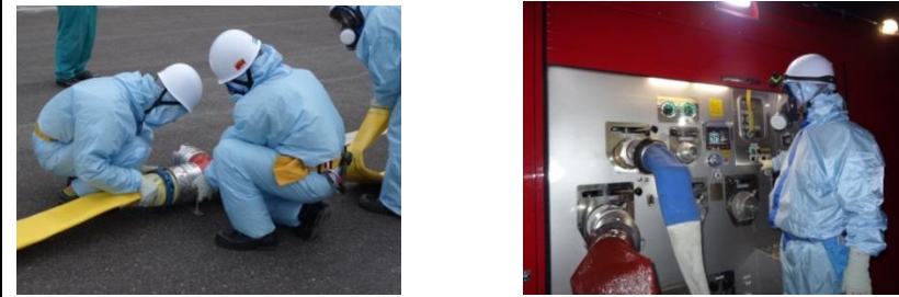
第3図 放射線防護具類を着用した状態での大量送水車設置作業
