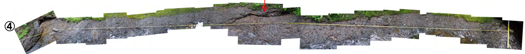
安山岩質凝灰角礫岩中の節理
