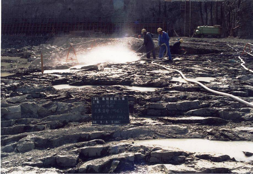
第1-1図 3号炉原子炉建屋基礎岩盤清浄状況 (平成27年3月20日審査会合資料再掲)
