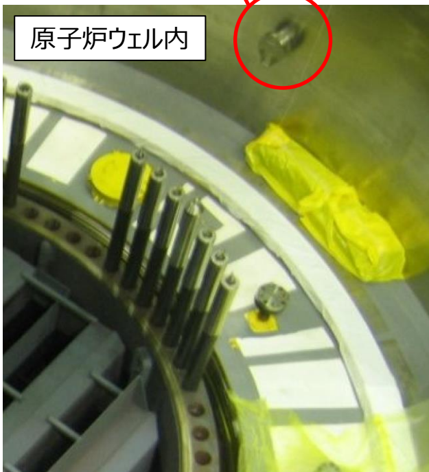
【定期点検中の写真】
