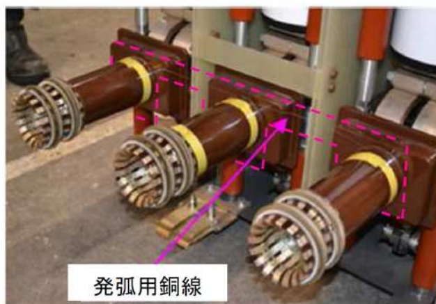
発弧線の設置状況(遮断器2次側端子)
