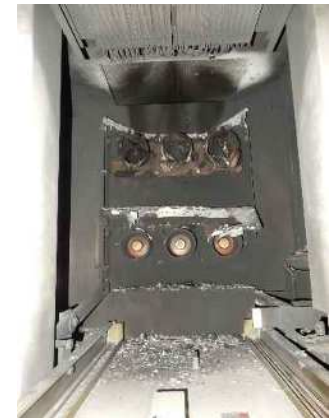
盤内開口部の状態(遮断器室)
