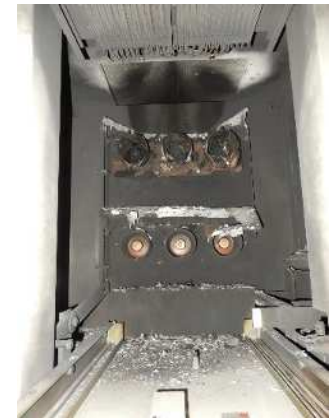
盤内開口部の状態（遮断器室）
