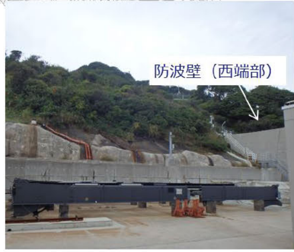
図2-21 防波壁西端部 状況写真
