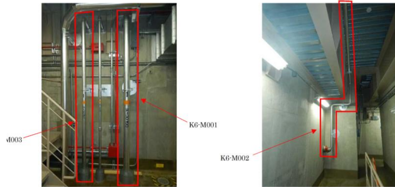
第1-4図 現場状況写真 (配管敷設状況)
