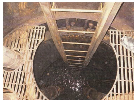
写真C 揚水井戸⑦(下段部) 2017/3/16撮影
