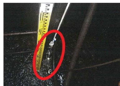
3号炉水位計の例(揚水井戸⑦)
