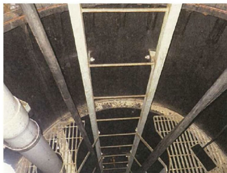
写真B 揚水井戸⑦(中間部) 2017/3/16撮影
