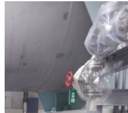
塗装・飛散防止カバーの例（試薬建屋）
