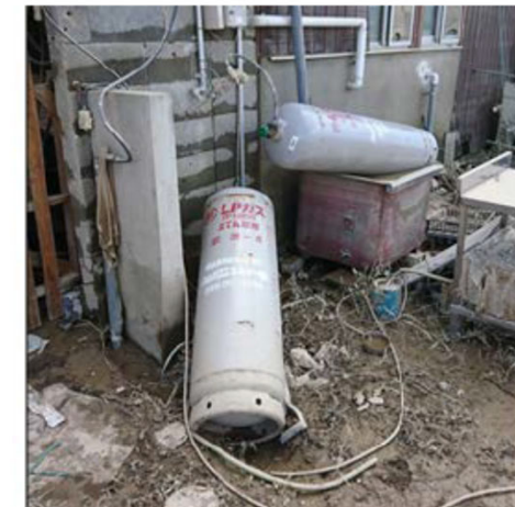
図 西日本豪雨による浸水後のLPガス容器の状況
