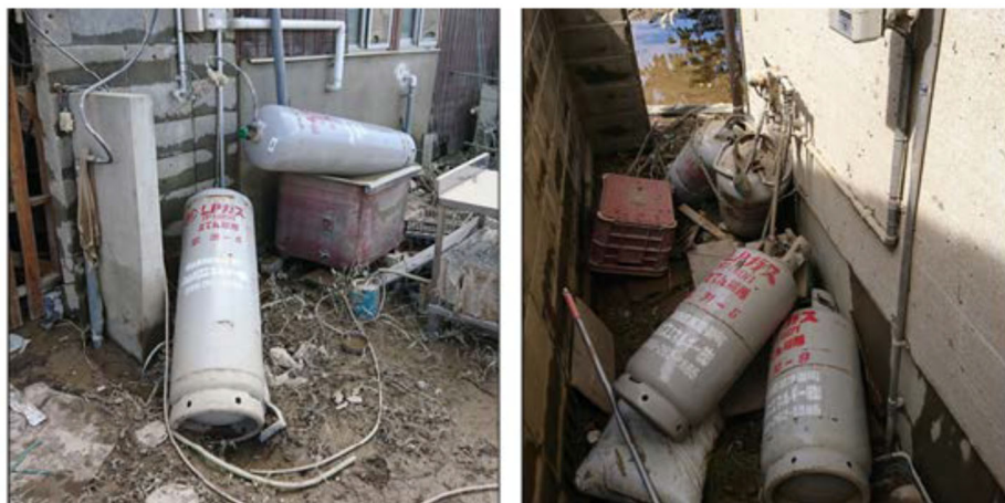
図1 西日本豪雨による浸水後のLPガス容器の状況
