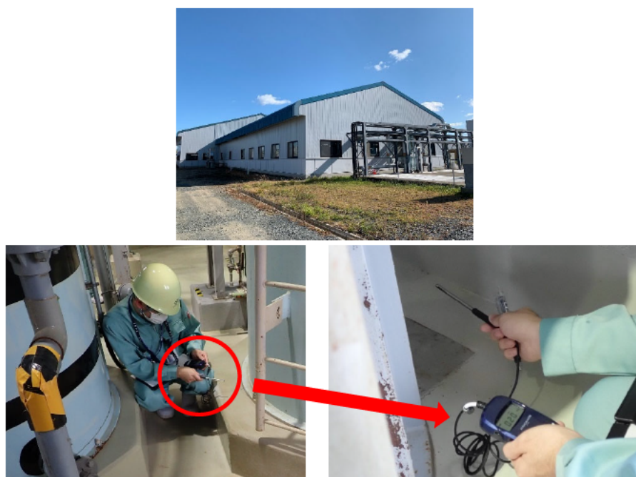
図4 タンク周りの風速及び温度の測定状況（第2一般排水処理建屋）
