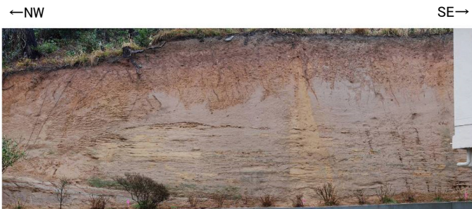
露頭写真(G-01露頭 NE面)
