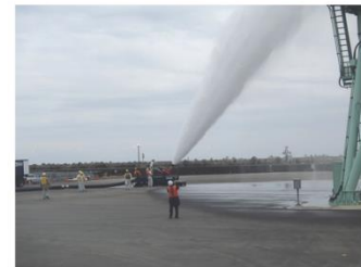
放水砲による放水 (噴霧放射)
