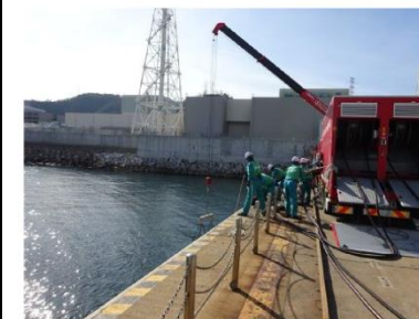
水中ポンプ設置の状況
