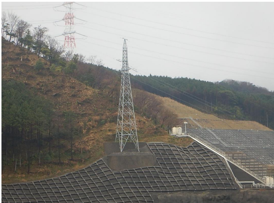
第 17 図 66kV 鹿島支線 No. 3 鉄塔設置状況
