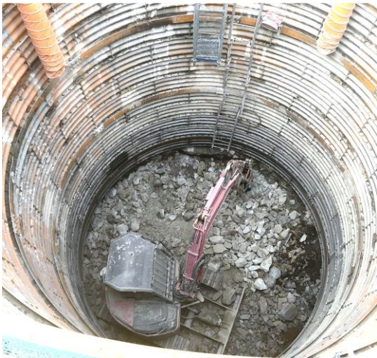
第 7. 4. 2-22 図 掘削状況写真
