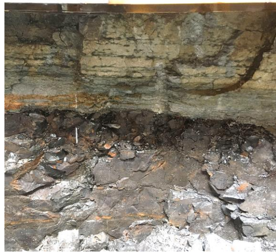
第 7. 4. 2-23 図 掘削面の近接写真
