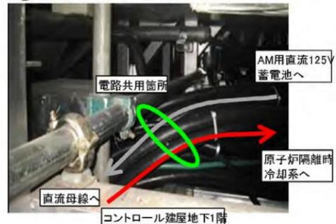
図 57-10-6 ケーブルトレイ共用電路 (7号炉)
