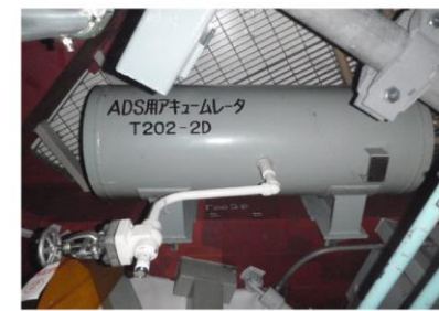
逃がし安全弁自動減圧機能用アキュムレータ
