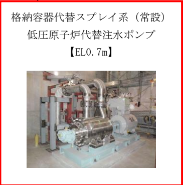
低圧原子炉代替注水ポンプ格納槽
