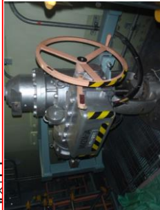
A - RHR熱交冷却水出口弁 (MV214-7A)
