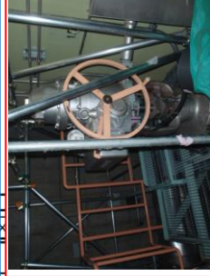
B - RHR熱交冷却水出口 (MV214-7B)
