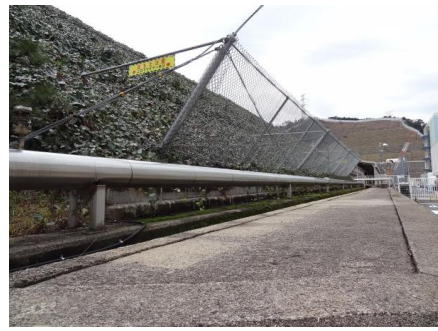
第 41-1-28 図 屋外消火配管への保温材設置状況
