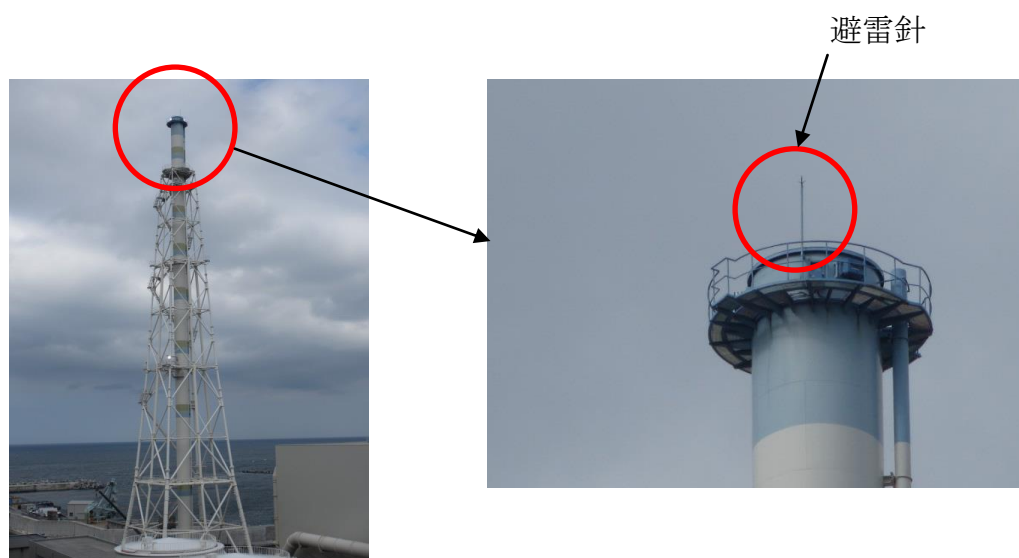
第41-1-12図 避雷設備の設置例 (排気筒)
