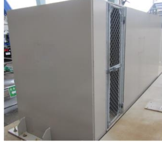
②0F ケーブルダクト吸気口, ③竜巻防護対策
