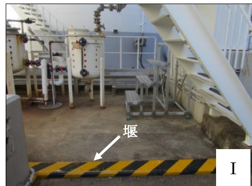
第2図 堰周りの状況 (排水中和用塩酸貯槽)
