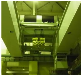
原子炉建物天井クレーン外観
