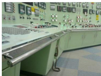
手摺設置状況
