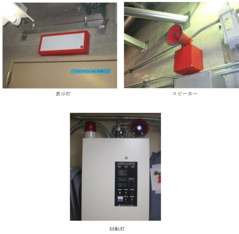
第 1-28 図：全域ガス消火設備、二酸化炭素消火設備の職員退避警報装置の例
