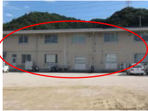
43 協力会社事務所北側ガラス窓 (4 4 m 盤)
