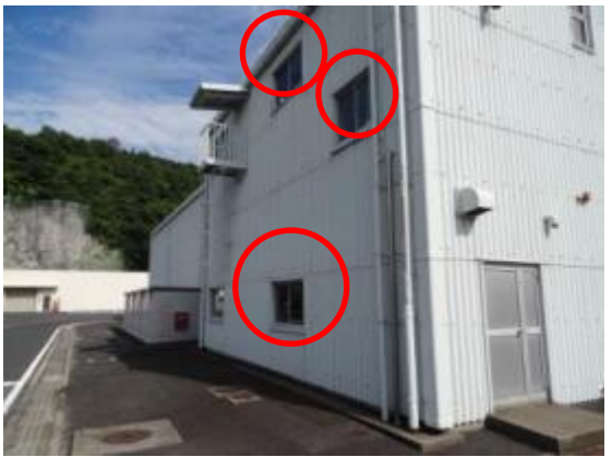
64 2号倉庫ガラス窓
