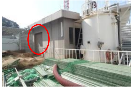
99 鉄イオン貯蔵建物南側シャッター
