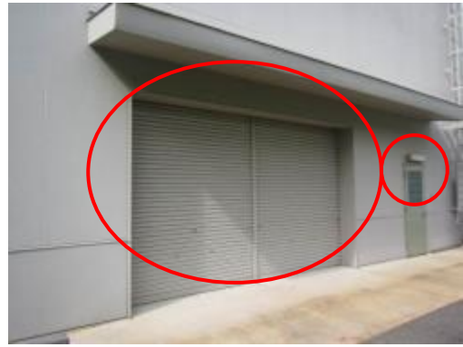
17 補機メンテナンス建物南側シャッター，ガラス窓
