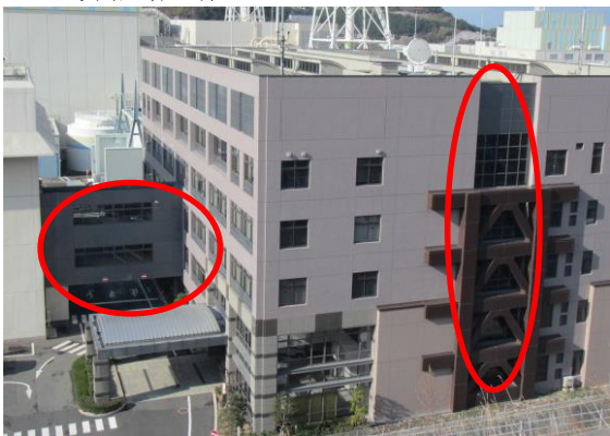
174 1号館管理事務所
