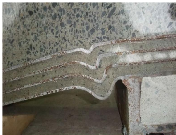
圧縮縁はらみ出し状況
