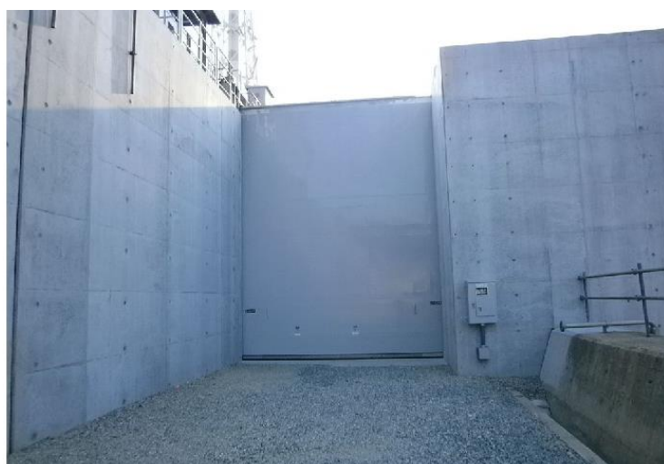
第 8-13 图 防波壁通路防波扉（1，2号炉北側）③ 設置狀況
