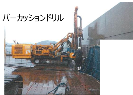
施工状況（削孔工）
