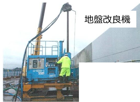
施工状況（造成工）
