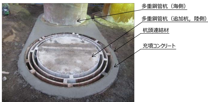
杭頭連結材設置状況 (間詰めコンクリート打設前)
