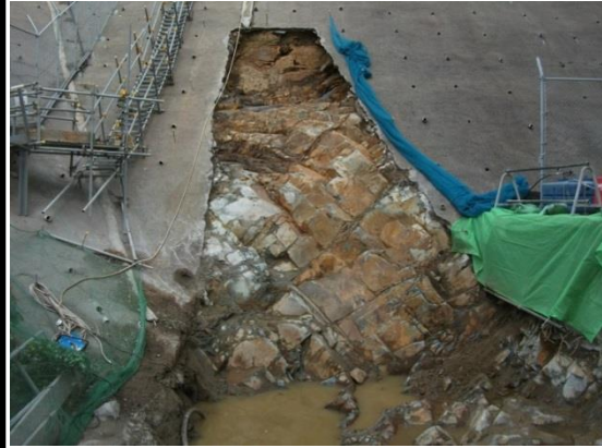
防波壁東端部 岩盤露出状況
