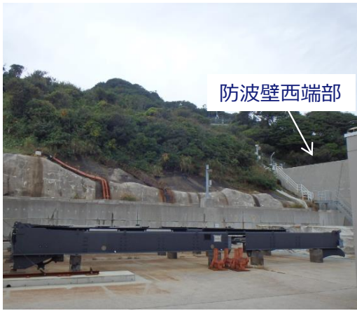
防波壁西端部 状況写真
