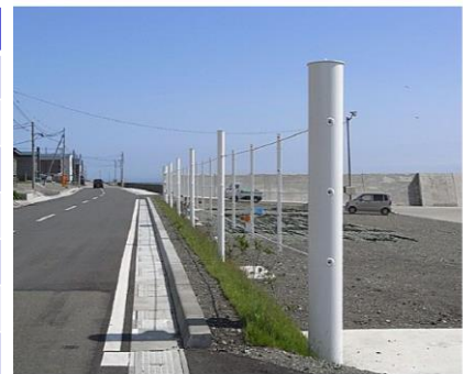
えりも港：漂流物対策工の設置状況
