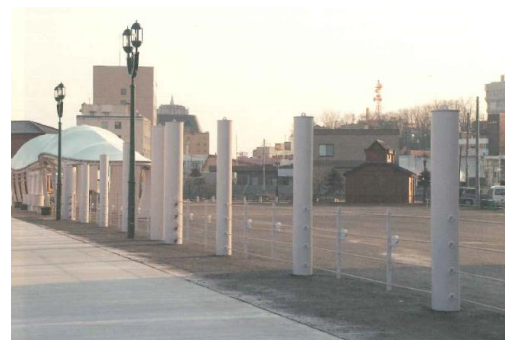
釧路港：漂流物対策工の設置状況
