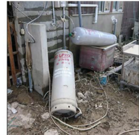
図 西日本豪雨による浸水後のLPガス容器の状況
