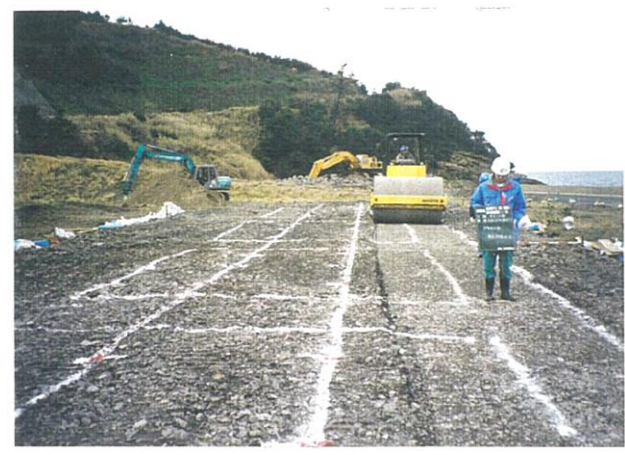
振動ローラによる転圧状況
