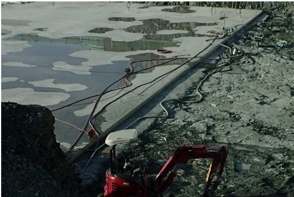
第1-2図 使用済燃料乾式貯蔵建屋 均しコンクリート打設状況
