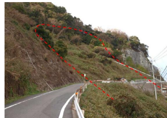
ブロック上部～中央部の斜面状況
