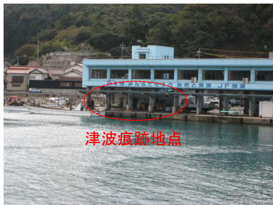
図2 痕跡地点周辺写真
