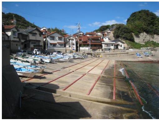
図2 痕跡地点周辺写真
