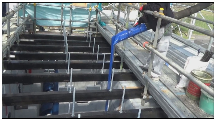
第 25 図 充填モルタル打込み状況
