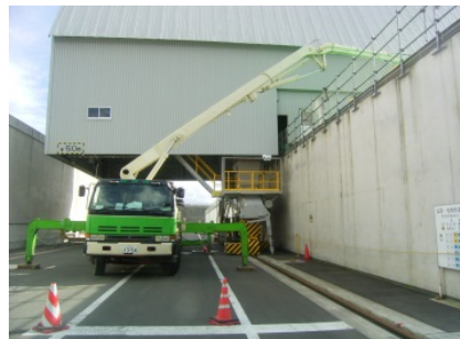
第4図 埋設設備内への充填材充填
