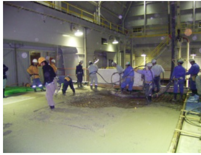
第5図 埋設設備区画上部への覆い設置
