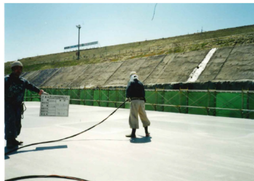
防水材吹付け
