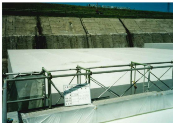
仕上げ材吹付け
