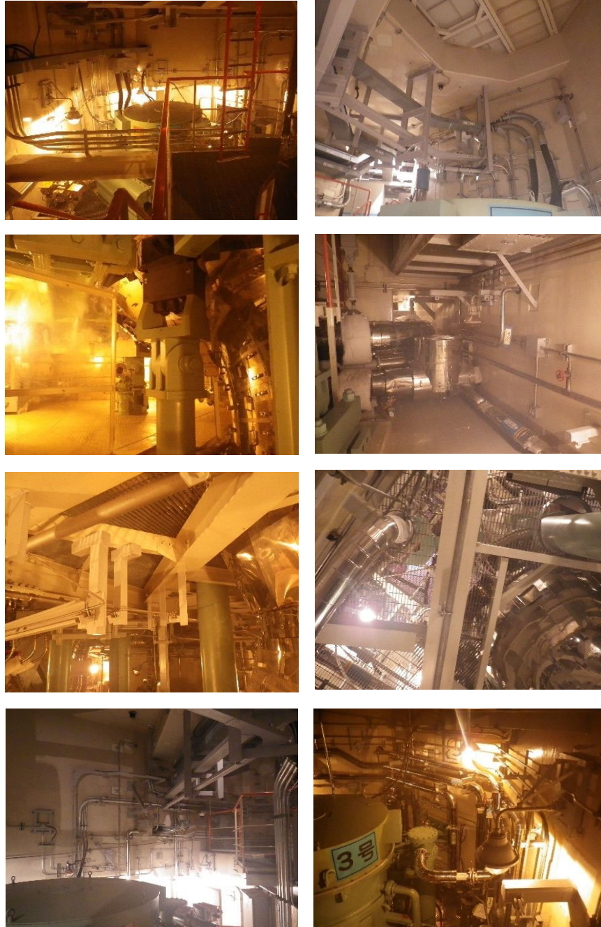
第 3-6-6 図 現場写真 (例：格納容器ループ室内)
